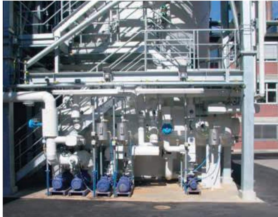
Detalle de la torre de escaleras con bombas de condensado
